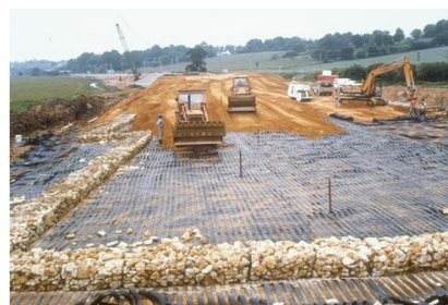
图 10 土工格栅加固超软土道路地基 Fig.10 Foundation improvement using geogrids
